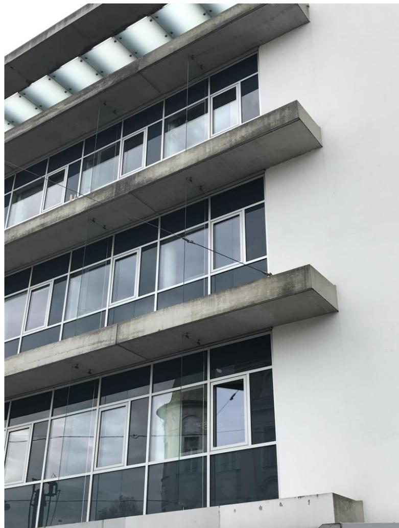
Schmutz und Rost entlang der Betonauskragungen – vorher - zu Beginn der Reinigung
