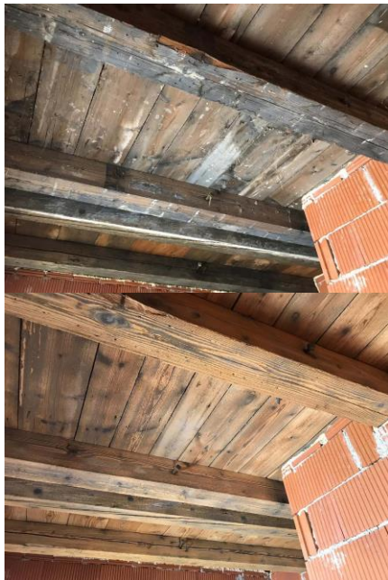
Alte Holzdecken werden durch Reinigung mit einem Sandstrahlgerät oder mit Trockeneis wieder wunderschön.
