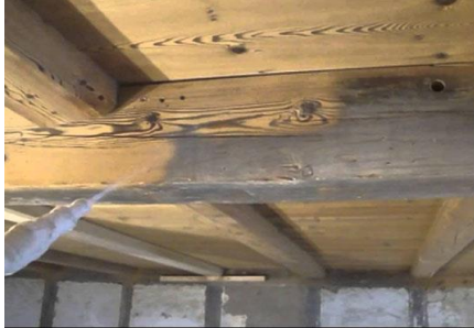
Alte Holzdecken werden durch Reinigung mit einem Sandstrahlgerät oder mit Trockeneis wieder wunderschön.
